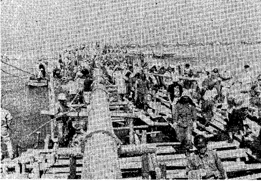
写真-8 同上 (サンドポンプ船は東海丸 D1350 中)
