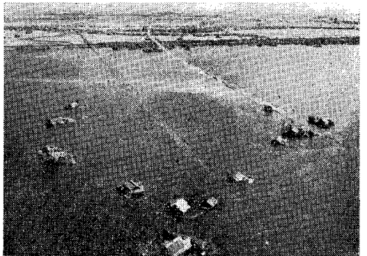
写真-13 国道1号線のドラムカン工法
