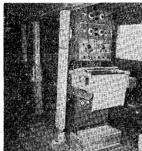
写真-5 器械の据付け
