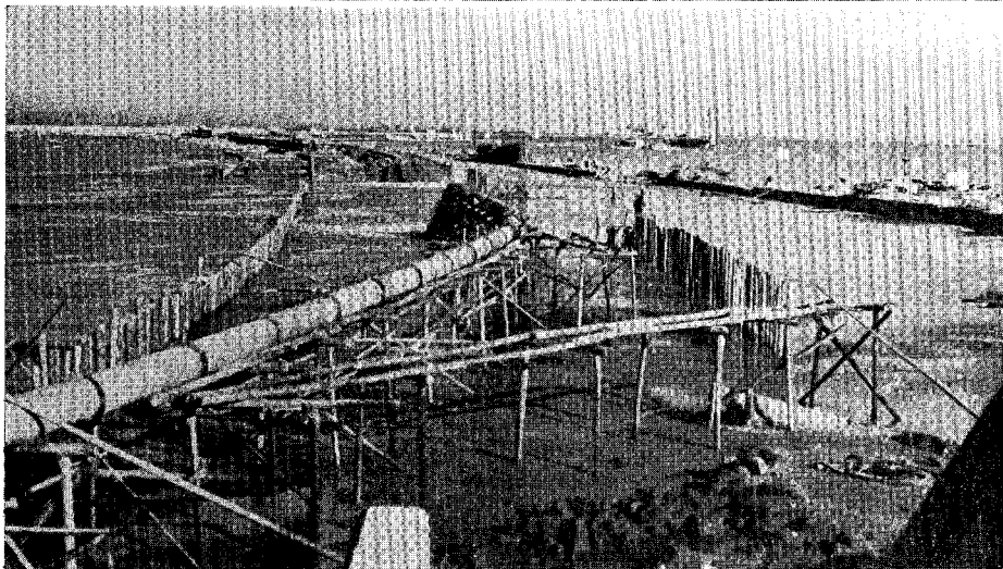
海部郡弥富町東末広地区の寸断された海岸堤防と応急工事
