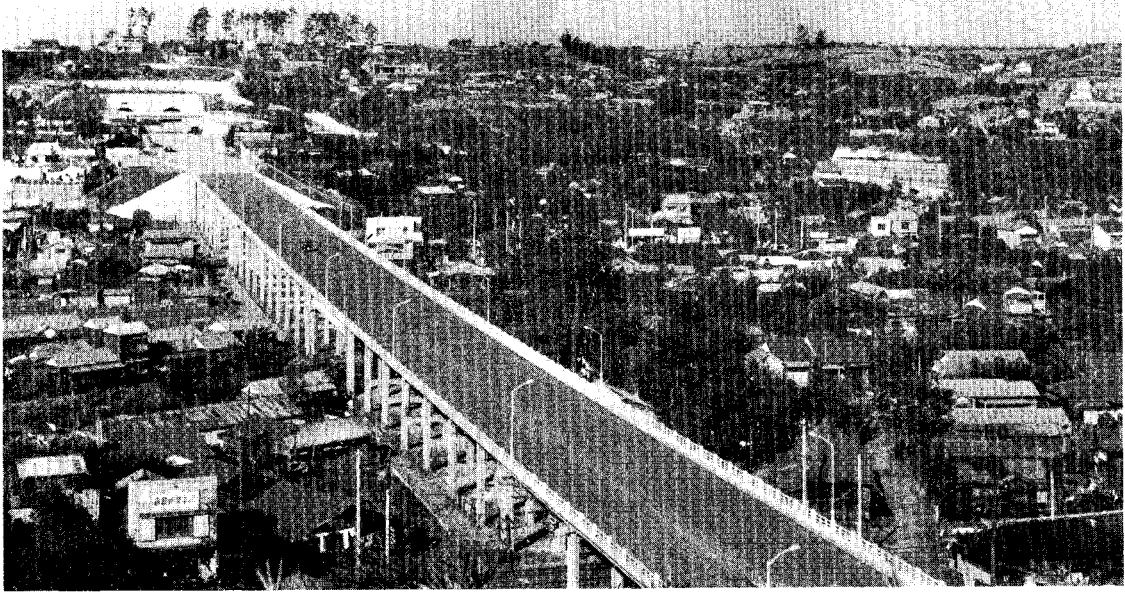
保土ヶ谷付近の高架橋とトンネル
