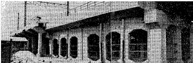
筑豊電鉄壁式高架橋
