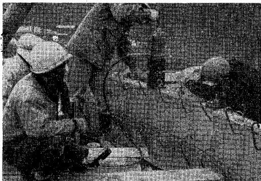
写真-11 フープ方向プレストレス導入作業
