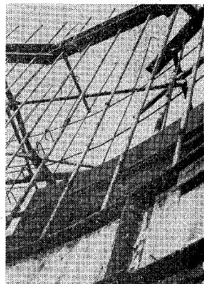
レキシブル シースを使用し、配力鉄筋およびPC鋼棒のシースなどに密に緊結し、蛇行するのを極力防止しプレストレス導入効果をあげるようにした(写真-6)。
