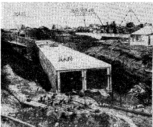
写真-3 取水路施工状況
