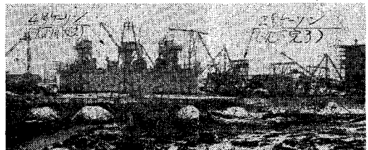
写真-9 ケーソン施工状況
