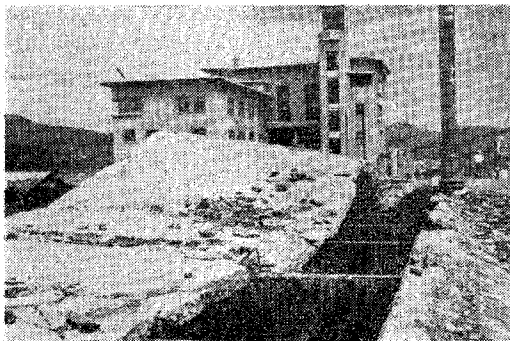
写真-2 被爆後の相生橋と商業会議所
