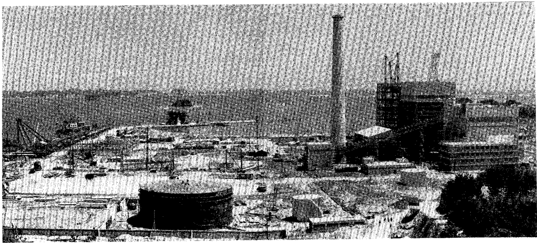
仙台火力発電所建設工事状況
