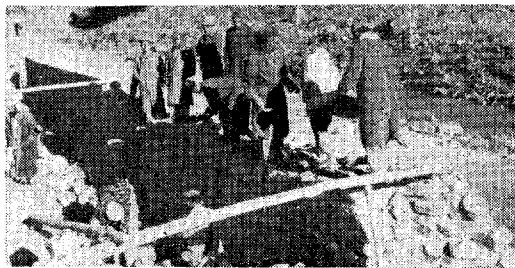
写真—6 請負業者による擁壁工事
