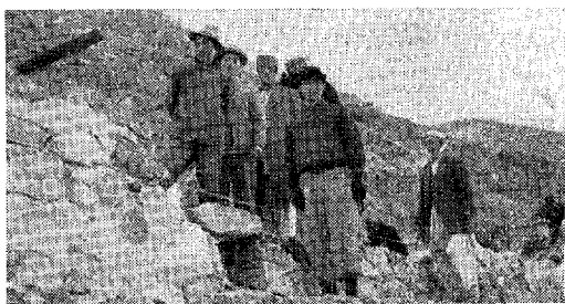
写真一 雑石積の擁壁
