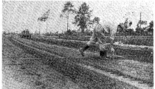
写真-3 横断の整形検査
