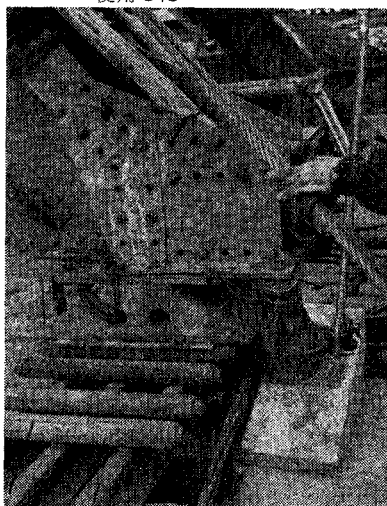
写真-7 写真-3 の拡幅は 37kg レール 3本の上に \phi 76 \times 609 のコロを並 べて 50t ジャッキをトラス両端に 使用した
