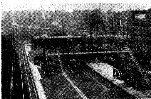
四谷駅付近（東京方より新宿方を望む） 手前：仮階段、中間：地下鉄からの連絡通路、右側：地下鉄駅、後方：地下鉄線路
