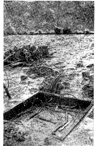
写真-4 ヒズミ計の埋設
