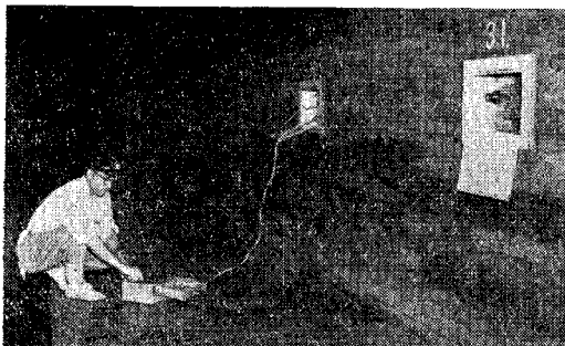
写真-5 監査廊内における計器測定
