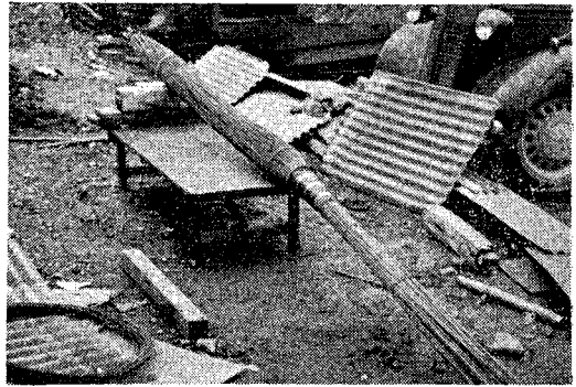
写真-7 定着頭部のコンクリート打ち
