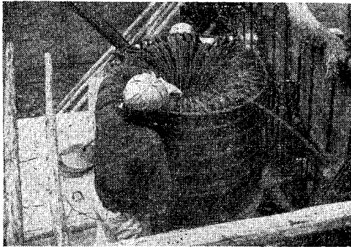
写真-4 定着頭部の製作 (補強鉄筋と 440 本の PC 鋼線)
