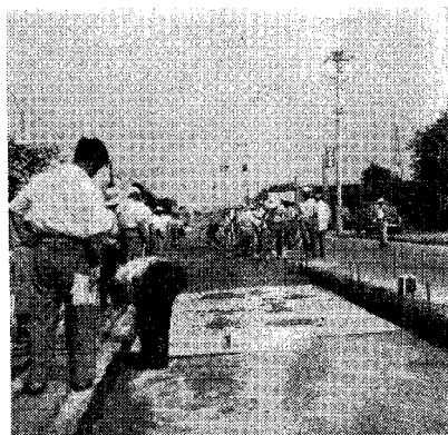
平塚付近真空コンクリート工法の施工状況(第1班)
