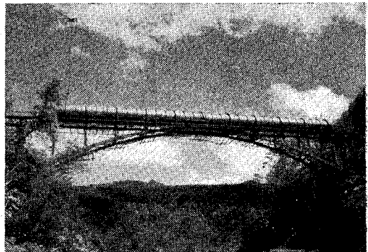
岩知志水路橋
