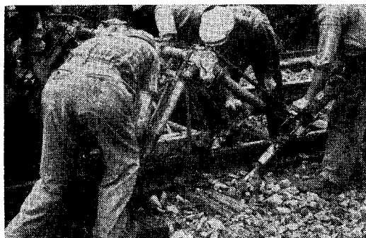
図-28 衝撃式マルチプル タイタンパー(イタリア)
