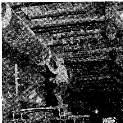
隧道用エアーダクト施工の実況 (福島県只見線滝沢隧道工事) 鹿島建設施工
