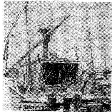
写真-7 機装中のケーソン
