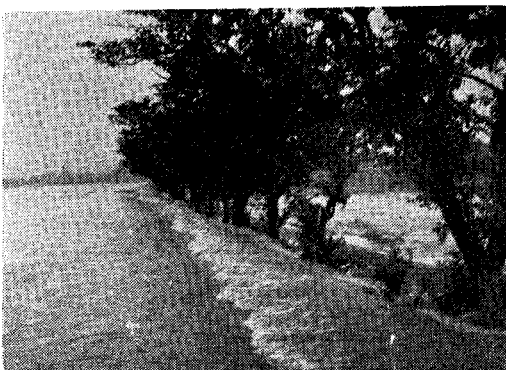
写真—1 東櫛原堤防取付附近破堤直前 (昭.28.6.26.17 時頃)
