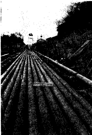
写真-3 Pipe yard に並べられた管条群 (右端が逆水線)
