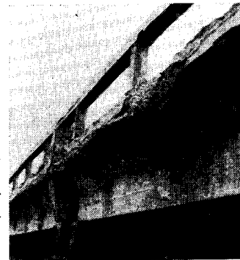
写真-3 南側スラブ端の被害状況
