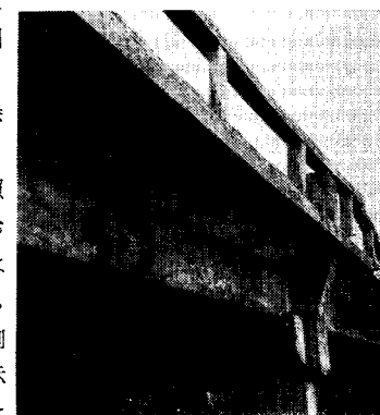
写真-4 北側スラブ端の状況
