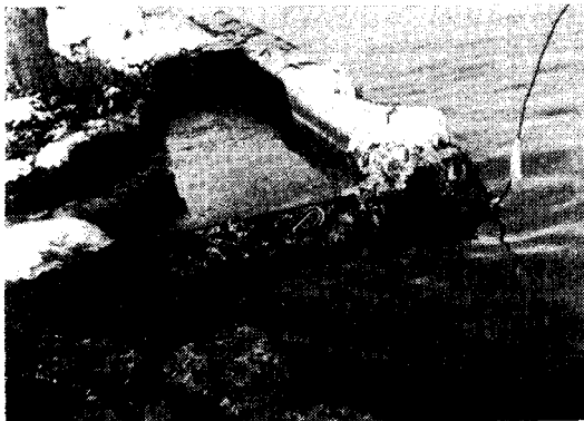
写真一9 ケーソンの被害状況
