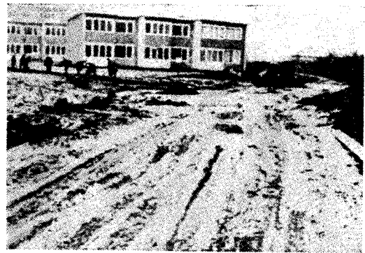
写真-2 緑石施工後に掘削し、地下埋設物を施工
