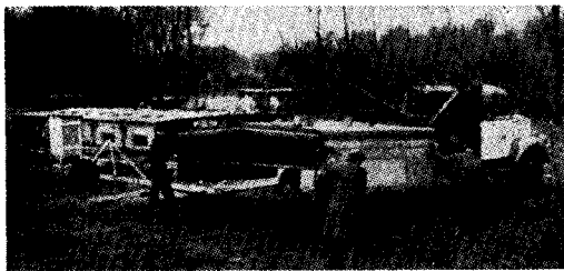
写真-3 冷凍管付きの絶縁蓋の設置
