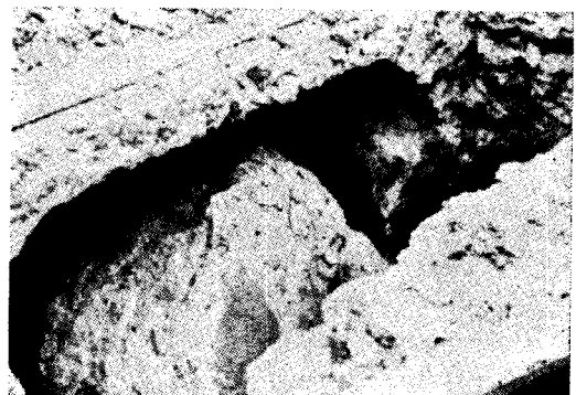
写真-3 悪い締固めのためできた穴
