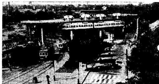
東京上野公園に完成したモノレール
