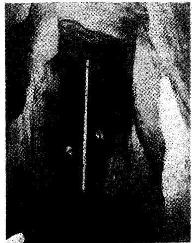
写真一 北海道足寄発電地点水路トンネル内のガマ
