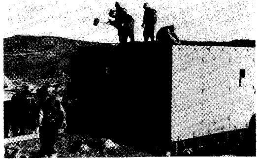
写真-2 建設中の無電棟
