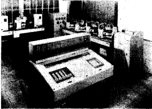
写真-2 継電器室
