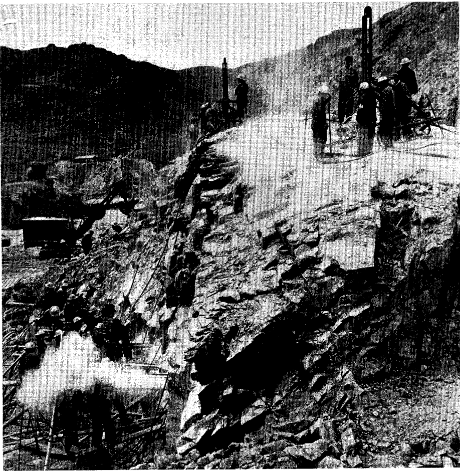
基礎岩盤の掘削状況
