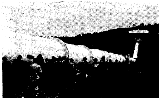
写真一20 足寄発電所水圧鉄管
