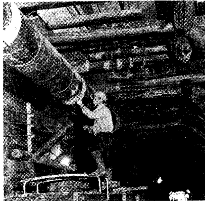
隧道用エアーダクト施工の実況 (福島県只見線滝沢隧道工事) 鹿野島建設工
