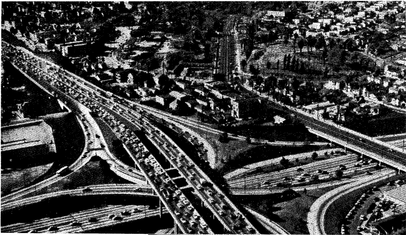
↑ロサンゼルス市 4層立体交叉施設
