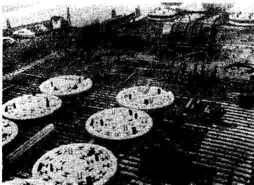
**2. 第2段階（図-2）** 測量用マストが取除けられたのち 65m までの H型断面の長い鋼杭が沓板の H型孔へ潜水夫の力を借りて通され、そして打込まれ、最後に H型孔を水中コンクリートで固定する。
