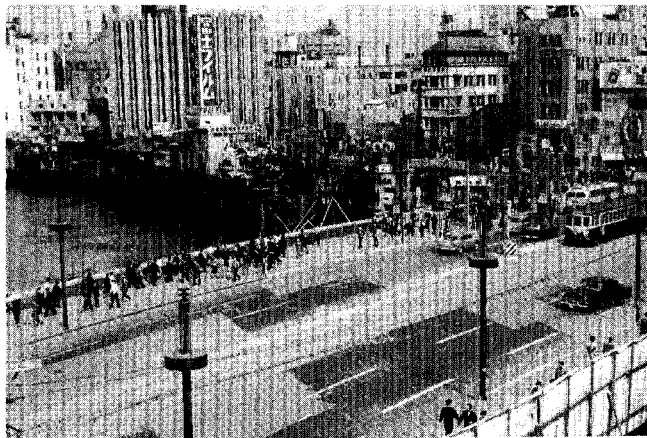
工事着手前の銀座数寄屋橋
