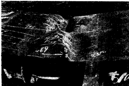
写真-4 箱桁の座屈状態
