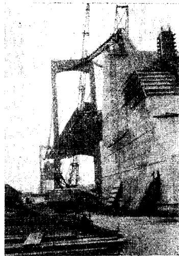
その開孔部を大写したのが写真-5であるが、グレーティングを通して塔の基部（写真の右端側）が望まれる。この基部に補剛トラスを支承するのにバッファーが設けられており、吊橋の減衰性を高める役目をしている。グレーティングの大きさは左端の靴先と比較してその程度の大体がわかる。
