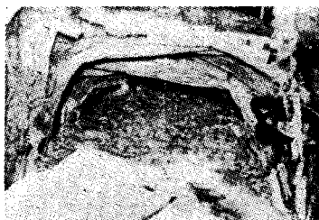
写真-2 圧気前、導坑切羽
