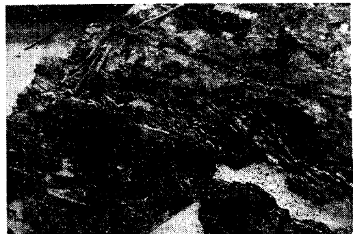
写真—2 大井川井川ダムの基礎岩盤
