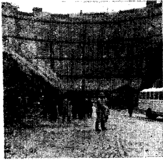
写真—2 鳴子ダム現場
