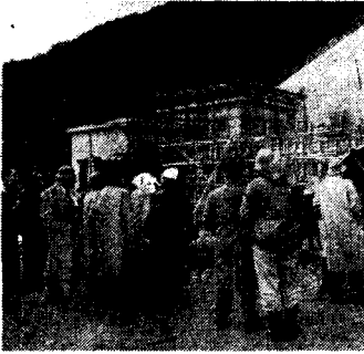
写真—3 発電所付近にて
