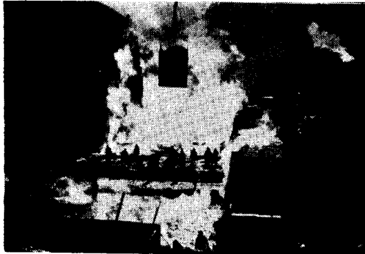
写真-6 No. 13, ブロック コンクリート 打込みとスチーム養生 (昭. 29. 11)
