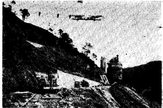
写真—3 ケーブルクレーンおよびパッチャプラント
