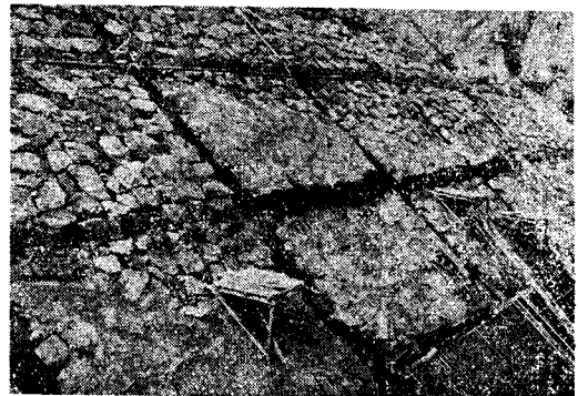
写真-5 野反ダムにおける肋材
