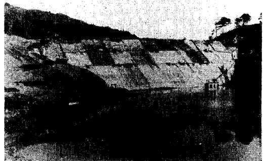
写真-7 ダムの上流側工事状況 (一部湛水中)
