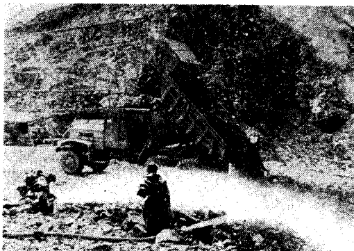
写真-3 水洗いの状況
