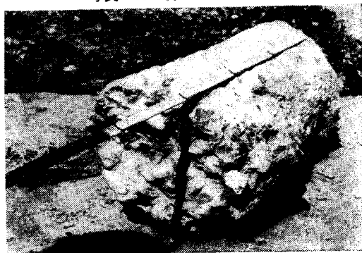
写真-10 杭頭部断面
