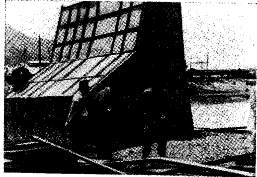
写真-7 水中部注入完了
