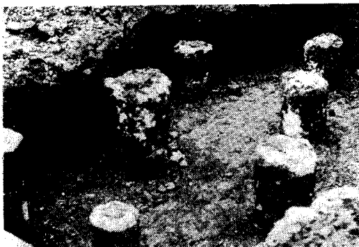
写真-9 掘り出されたプレパクトコンクリート杭
