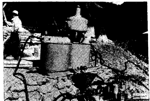
写真—1 モルタルミキサ (上) および グラウトポンプ (下)
