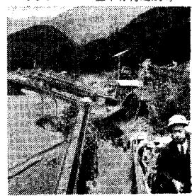
写真-11 井川ダムコンクリート打設現場
