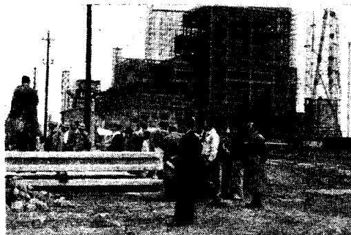
写真-16 石炭埠頭工事（ウェル頭部コンクリート工事）
