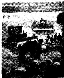
まづ作業員全員の土俵拵えに始まり、愛知県水防団による木流工、竹流工、蓮張工、岐阜県水防団による杭打積土俵工、三重県水防団による五徳工、積土俵工、月の輪工が次々と実施せられ、日頃の水防訓練の手なみを遺憾なく發揮し、ことに月の輪工には建設省よりブルドーザ4台が参加して機械化作業の偉力をを見せ参観者に強い感銘を与えた。
