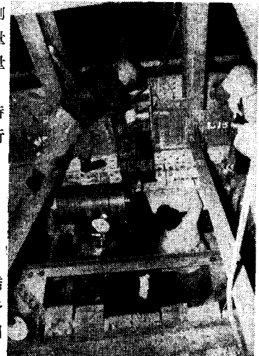
図-18 下弦側クラウンのジャッキ推力の添加
