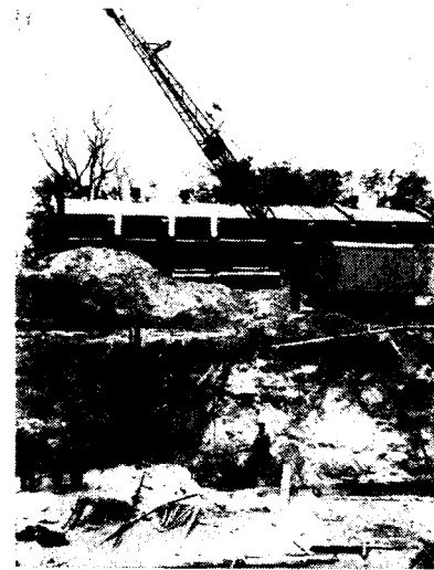
写真—2 地盤が固いためクレーンにより Well-points 挿入の外管を打込み作業中
