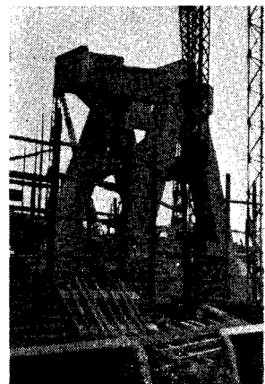
写真-2 完成した A 型脚構
