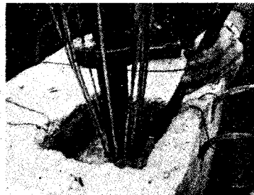
写真-5 くさび形アンカーの打込み
