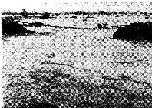
写真-6 福岡県沖端川新村橋上流 右岸欠潰
