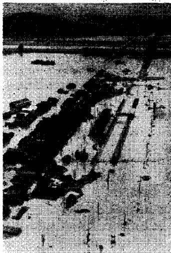
写真-4 水没した遠賀川駅
