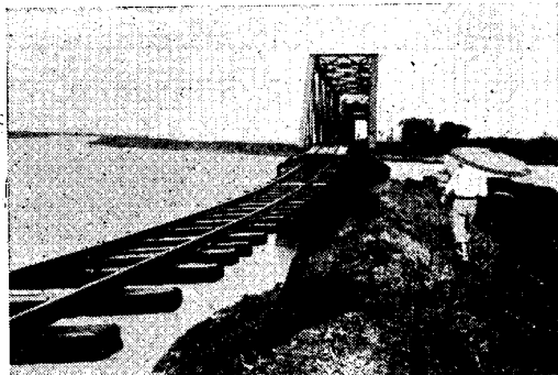
写真-9 矢部川鉄橋の流失現場
