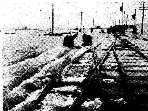
写真-8 築豊本線築前植生-築前 植木間線路浸水
