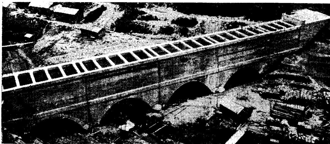
写真—1 竣工した真人沢水路橋
